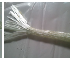
Step 6: Fiocco prima dell'inserimento nel perforo
