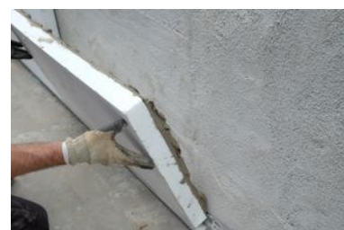
Posizionamento del pannello Kimitherm EPS 100
