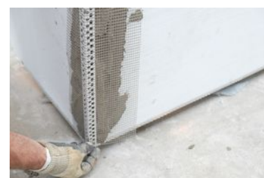
Applicazione del profilo angolare Kimitherm CORNER PVC
