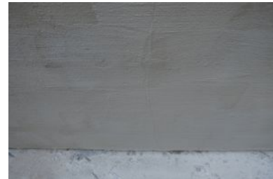
Completamento della rasatura
