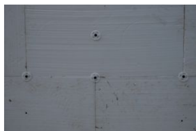
Fissaggio dei pannelli con il sistema di fissaggio Kimitherm T-CONNECT
