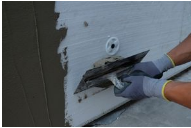
Applicazione della malta Betonfix TERMORASA
