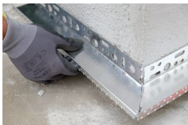
Posizionamento del profilo di partenza Kimitherm ALU START
