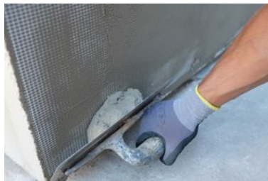
Applicazione del secondo strato di malta Betonfix TERMORASA
