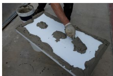
Applicazione della malta Betonfix TERMORASA
