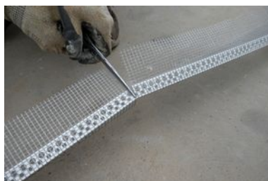
Taglio del profilo angolare Kimitherm CORNER PVC
