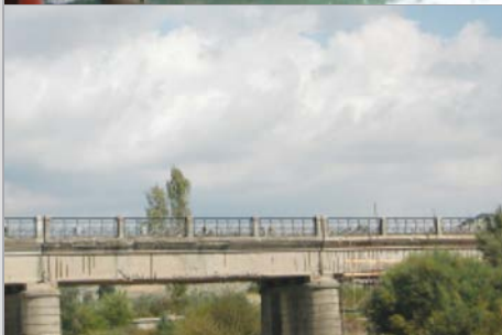
Ponte Sul Fiume Uria Amm.ne Prov.le Catanzaro
