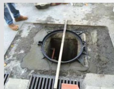
Getto di livellamento a copertura delle flange della cornice del chiusino prima di primerizzare ed applicare l'asfalto
