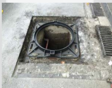
Posizionamento della cornice del tombino e messa in quota
