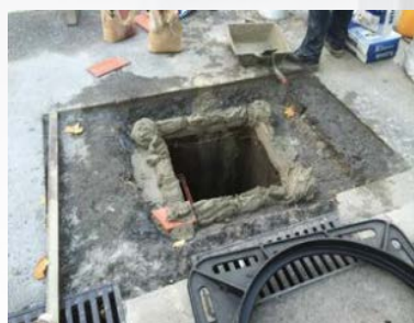
Applicazione della malta Betonfix FLC per il fissaggio del tombino
