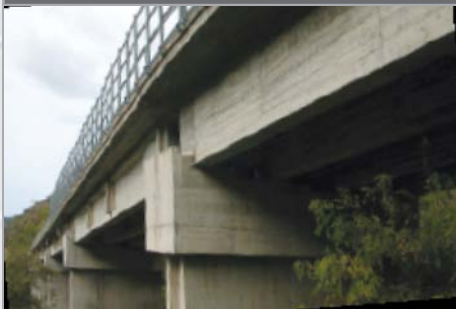
Ponte sul fiume Savuto ANAS S.p.A.
