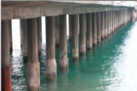
Ristrutturazione e recupero del pontile Gioia Tauro Comune di Gioia Tauro
