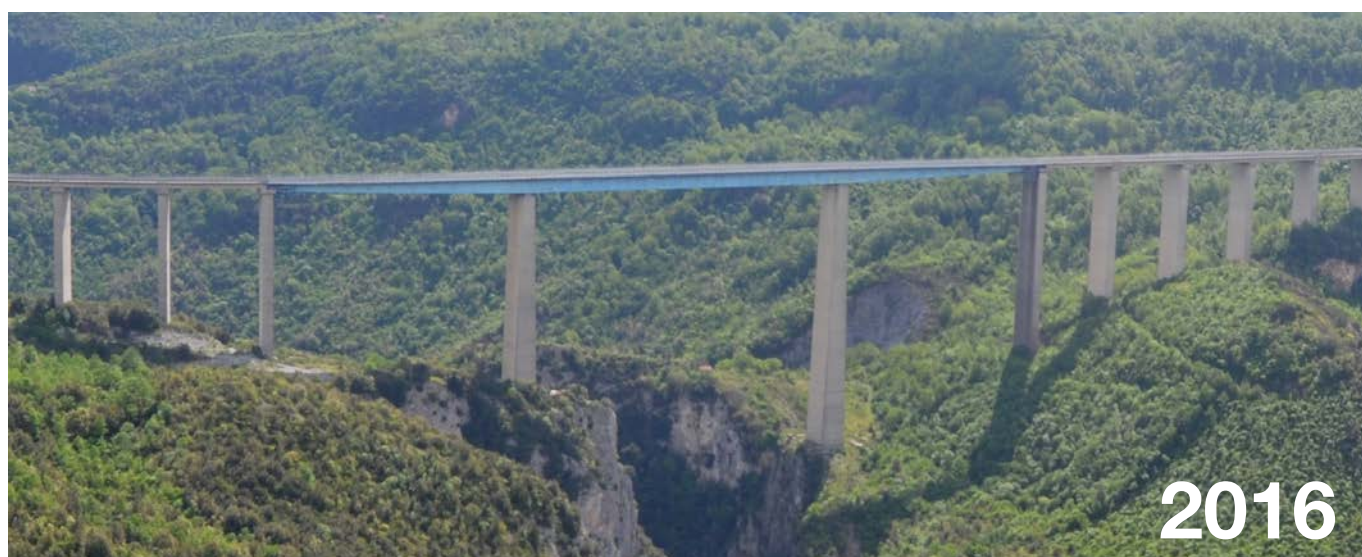
Viadotto Italia, Autostrada A3 (CS). La tecnologia Kimia ha raggiunto anche il viadotto più alto d'Italia, con i consolidamenti effettuati sulle pile tramite fasciature in carbonio.
