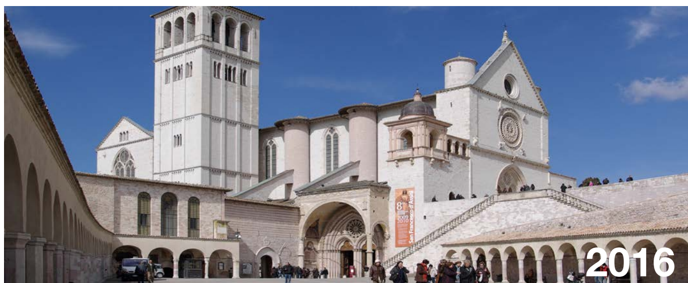
Basilica di San Francesco d'Assisi (PG). Consolidamento strutturale di parte del complesso monumentale con la fasciatura dei pilastri, in fibra di carbonio.
