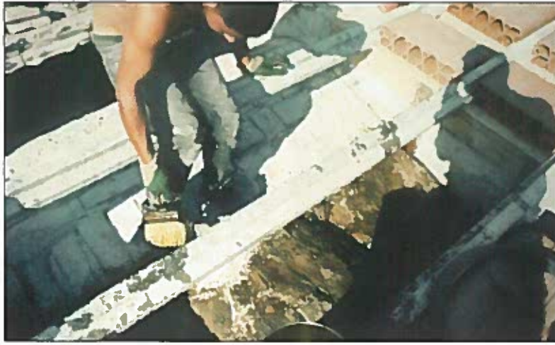
Fig. 7 Per il consolidamento del tetto, la realizzazione del mantello in betoncino epossidico è stata preceduta da una mano di resina bicomponente. (foto Kimia)
