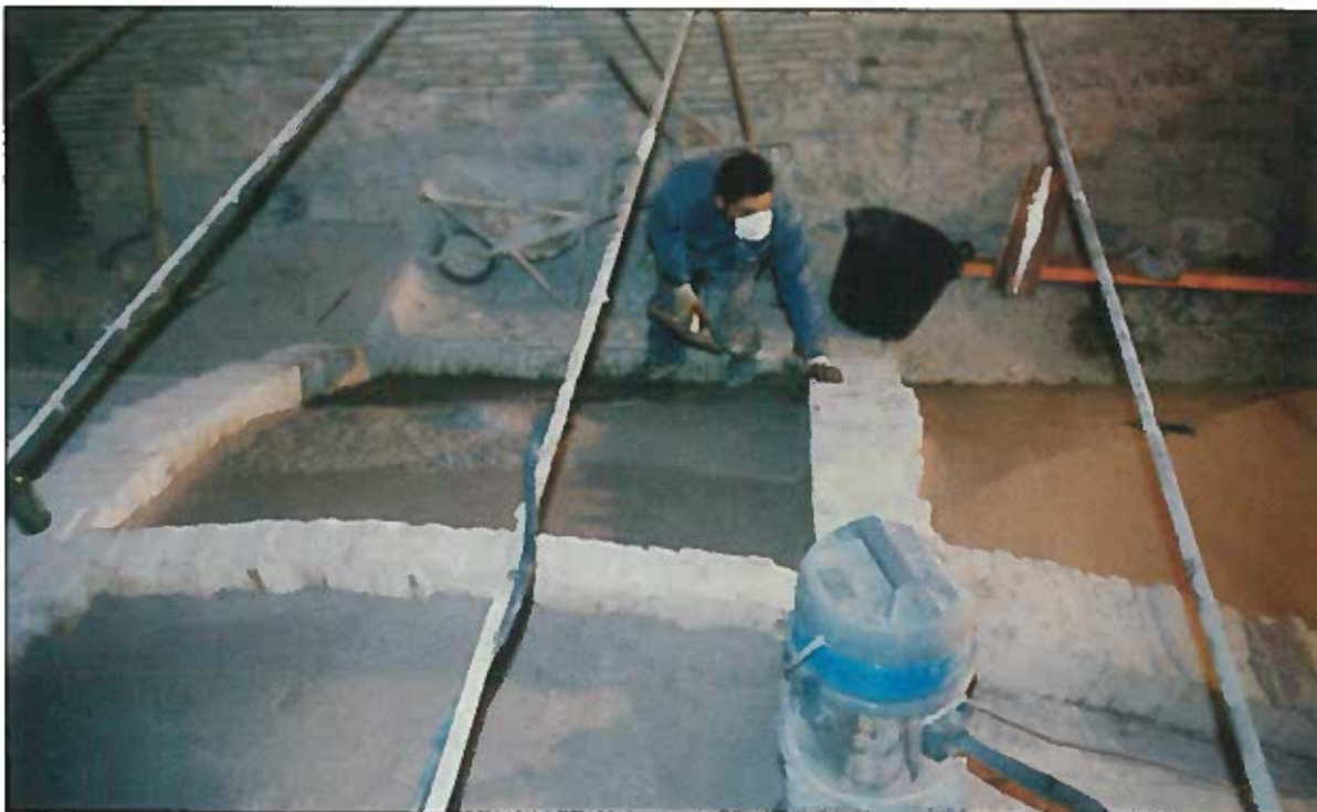
Fig. 4 La stesura del massetto epossidico sull'estradosso delle volte interne è stato preceduto da un'accurata rimozione del materiale di risulta che le appesantiva pericolosamente. (foto Kimia)
