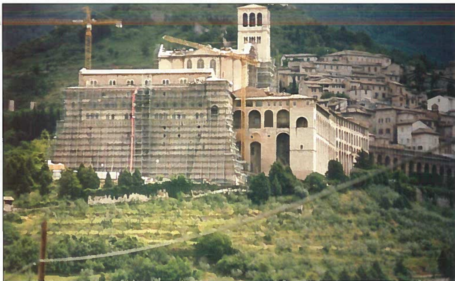
Il complesso basilicale di Assisi insiste su un colle di notevole pendenza. Lo sperone (sulla sinistra) venne realizzato nel XVI secolo per contenere lo slittamento dell'edificio verso valle.
