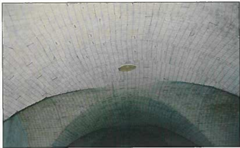
Fig. 5 La doppia armatura in acciaio sull'intradosso delle volte: la prima armatura è già stata completamente coperta con la malta. (foto Kimia)
