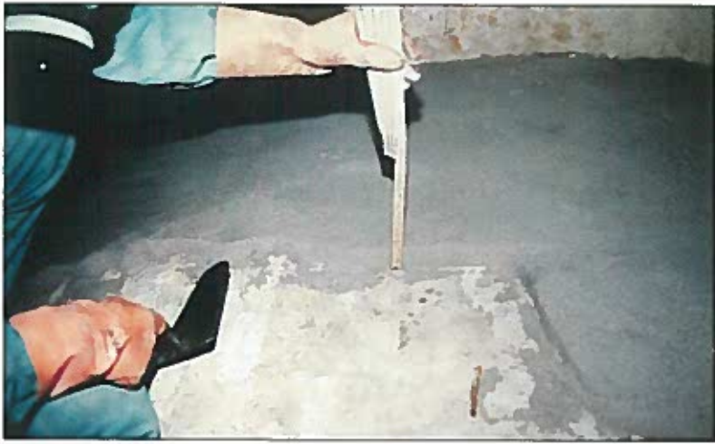
Fig. 3 Il mantello di copertura delle volte interne del Sacro Convento consiste in un massetto realizzato con resina epossidica bicomponente. (foto Kimia)
