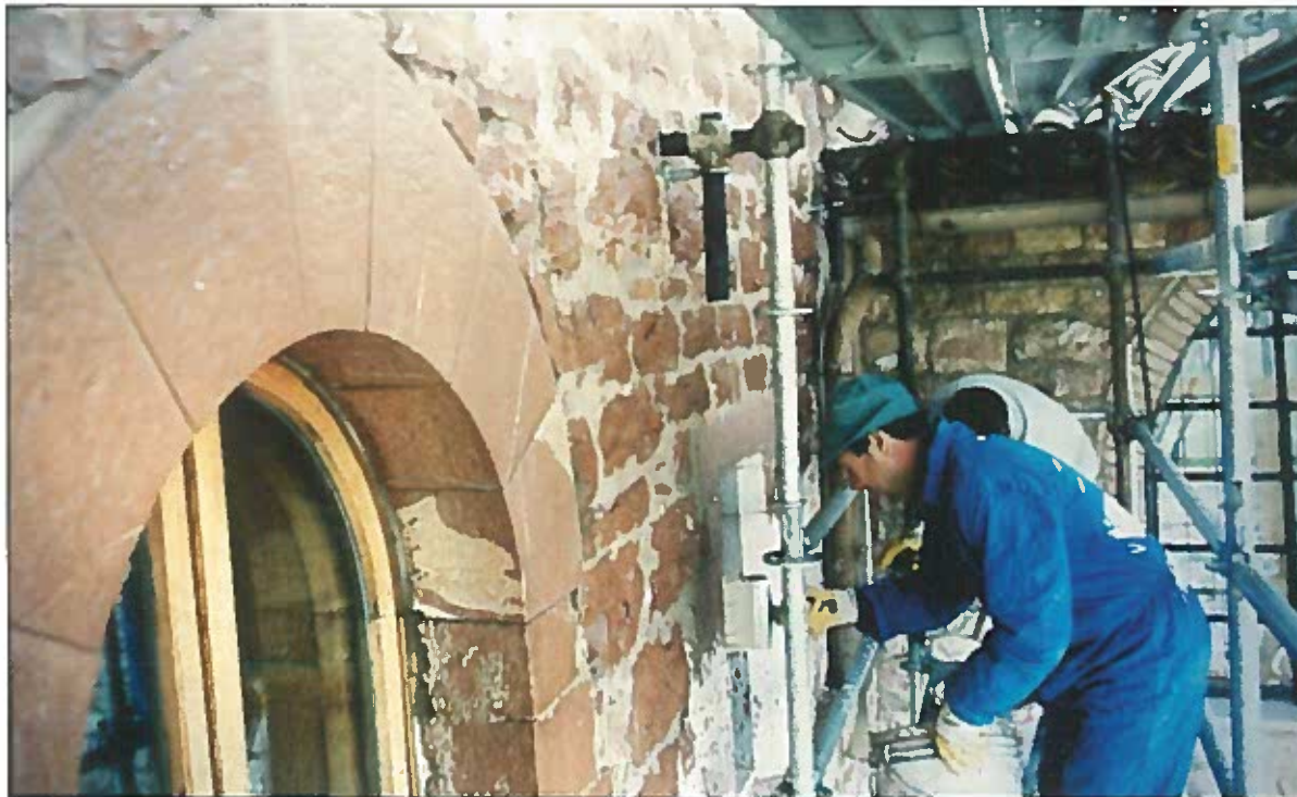
Fig. 8 Sui paramenti esterni, dopo un'accurata pulitura, è stato applicato un protettivo idrorepellente con elevata capacità di penetrazione (foto Kimia).
